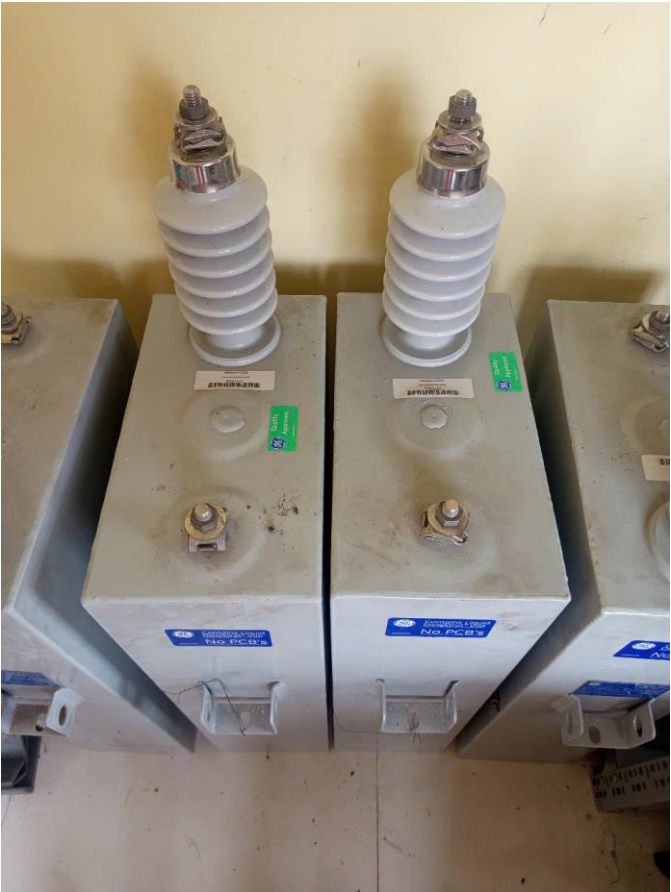
Hình ảnh bình tụ cao áp của TBD 502 - TBA 500kV Thạnh Mỹ
